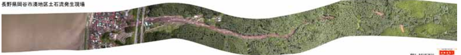
長野県岡谷市湊地区土石流発生現場
